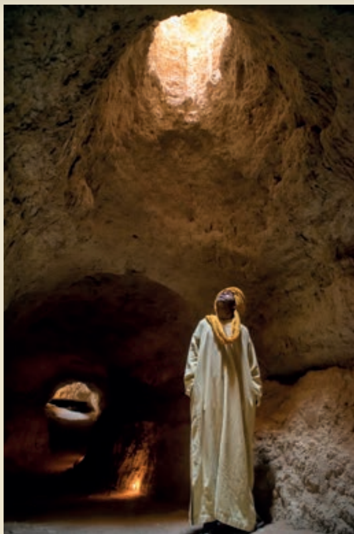
Puits d'aération des kettharas dans la région du Tafilalet (Maroc) entre Jorf et Rissani
