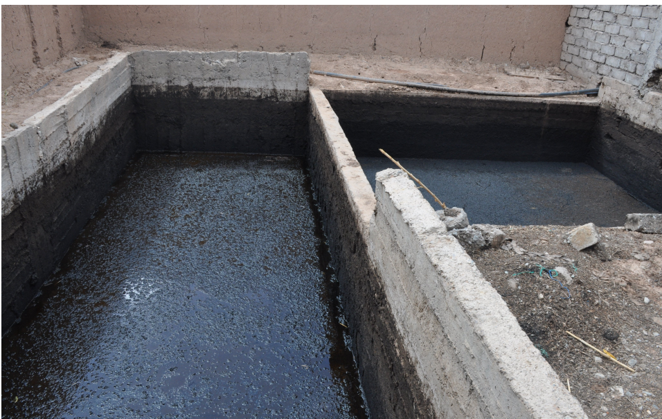
Bassin de récupération des grignons
