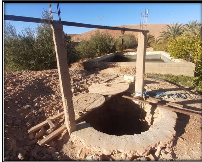
Photo 2 : Exemple d'un puits traditionnel connecté à un bassin d'accumulation
