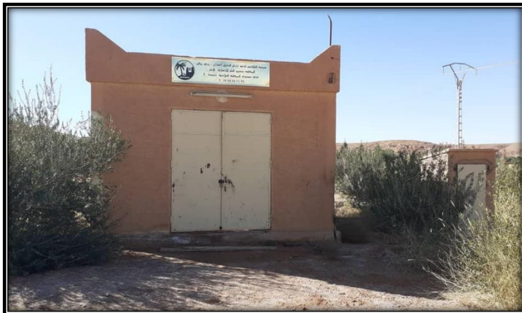
Photo 4 : Abris d'un forage collectif
