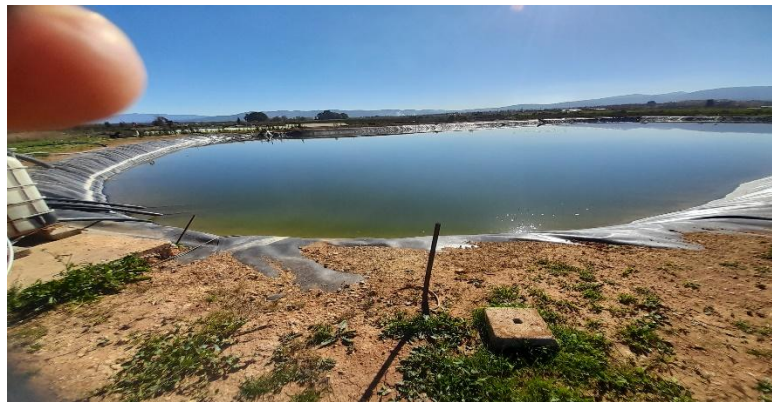
Photo 20 - Projet CARI : Bassin à membrane de stockage de l'eau au niveau de l'exploitation
